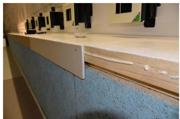
Bild 4: Verkleidung Kantholz mit Gipskarton
