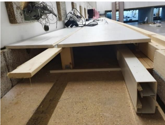
Bild 8: Kabelkanal mit Trennsteg (Bauphase)
