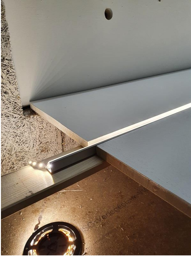
Bild 15: LED Aluminiumwinkel (Bauphase)
