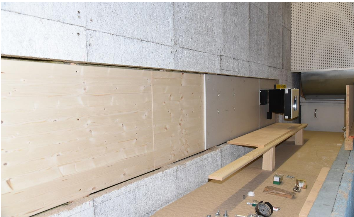
Bild 1: Leimholzplatten mit befestigter Gipskartonplatte (Bauphase)
