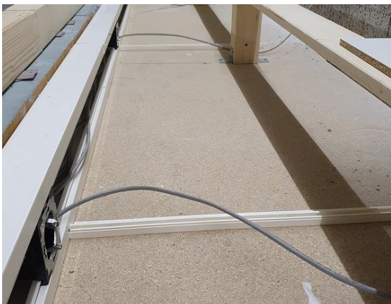
Bild 6: Kabelkanäle (Bauphase)
