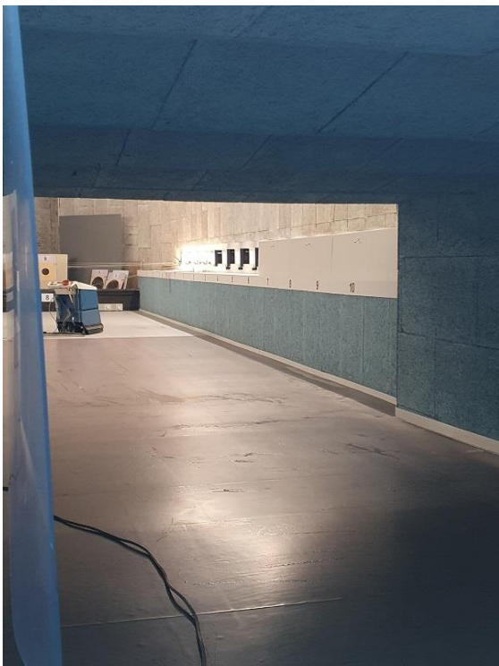
Bild 2: Ableitplatten geschlossen
